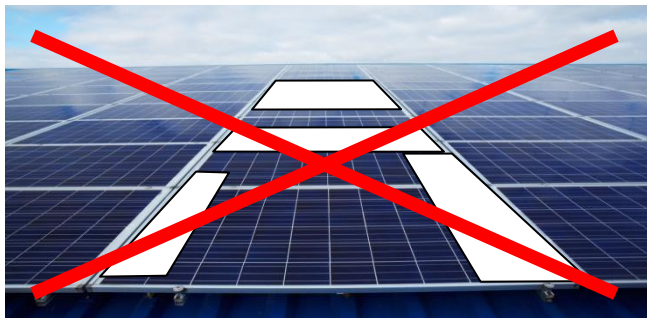
Abb. 4: Falsche Anordnung der SMB SOLAR-MULTIBOARDS
