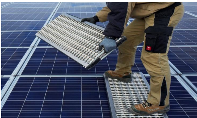
Abb. 7: Verlegen der SMB SOLAR-MULTIBOARD's
