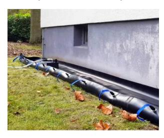
... und mit Hilfe der Spanngurte blitzschnell zu einer sicheren und stabilen Wanne geformt.
