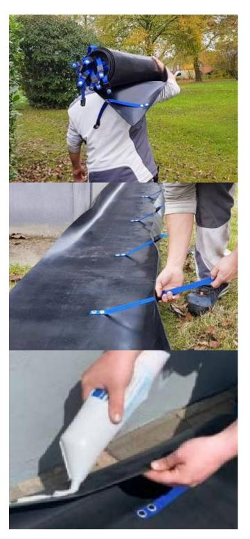
Abdichtpaste auftragen, Auffangwanne an der Fassade festdrücken und glatt ziehen.
