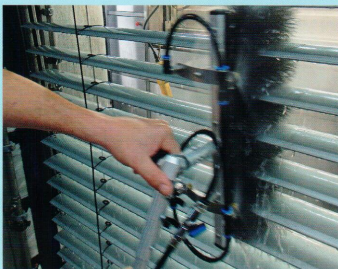
Feststehende Bürsten reinigen nach Einschätzung des VDS bei starker Verschmutzung hingegen nicht optimal.
